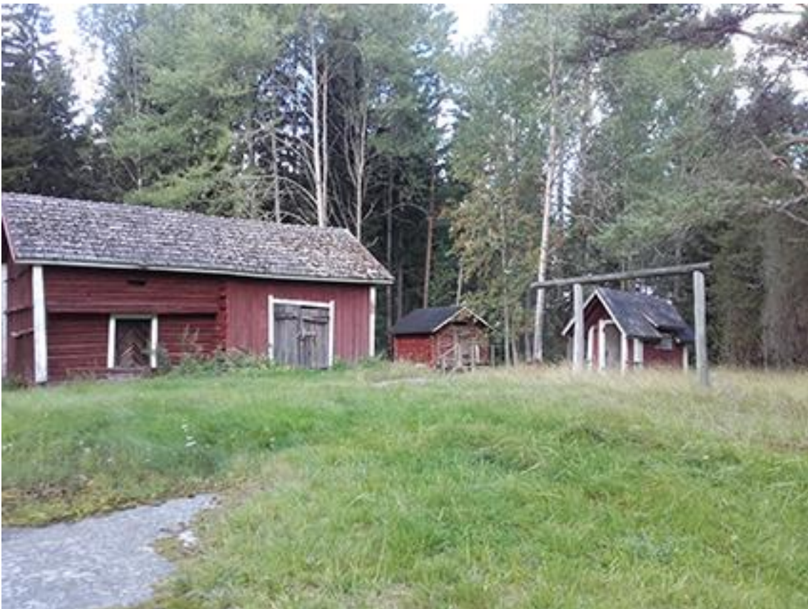
Bild 2. Tre av uthusen. Byggnaden till vänster och i mitten kan vara av samma ålder som huvudbyggnaden dvs. flyttad till tomten i slutet av 1700-talet. Lekstugan till höger är tillsnickrad 1959-61.
