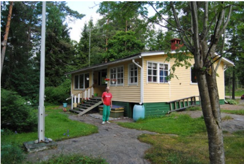
Bild 12. Den ursprungliga verandan är ombyggd till ett rum. Egentlig terrass saknas.
