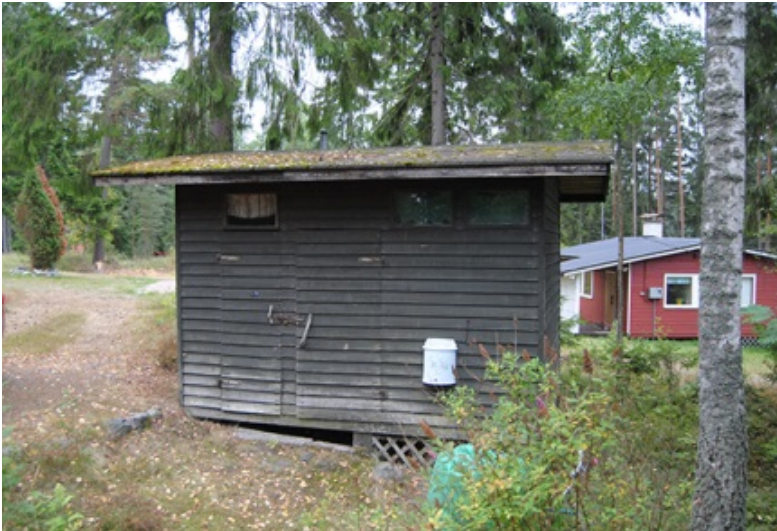
Bild 14. Ekonomibygggnad, i bakgrunden huvudbyggnaden.
