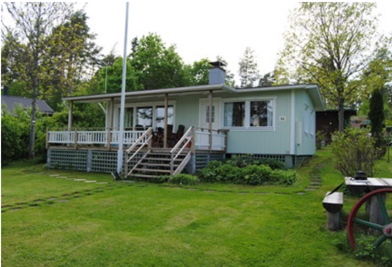
Bild 9. En typisk huvudbyggnad från 1970-talet. Byggnaden är grundrenoverad.
