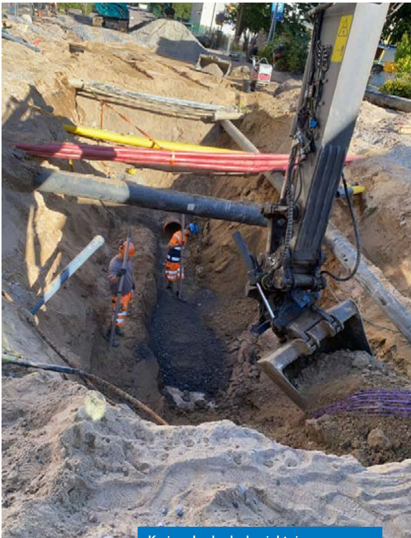
Karjaan Laaksokadun johtojen saneeraus.
