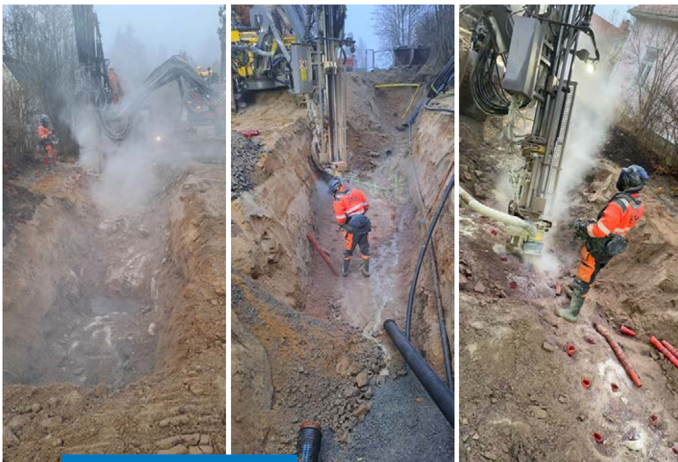
Karjaan Vuorikadun johtojen saneeraus.
