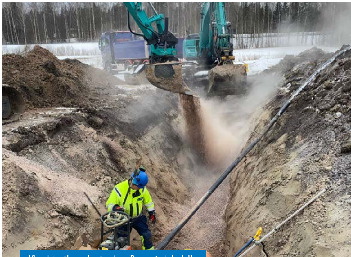
Viemäriputken rakentaminen Pormestarinkadulla.
