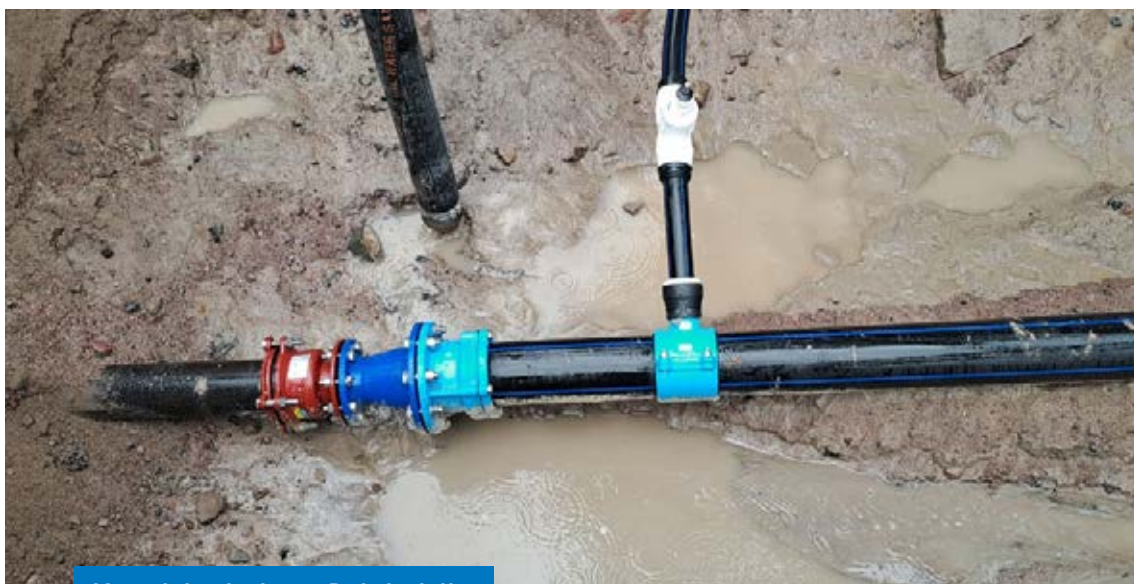
Vesijohdon kytkentä Pitkädulla.
