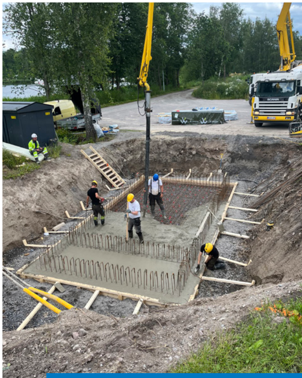
Skeppsholmenin jätevedenpuhdistamon uusi hiekanerotusallas rakennusvaiheessa ja valmiina.
