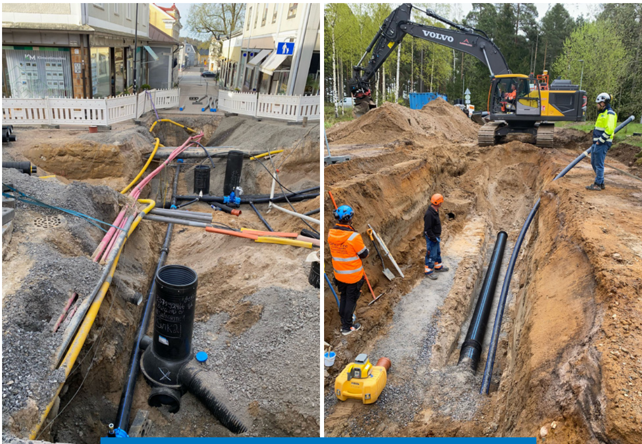
Sanering av ledningar vid Kungsgatan i Ekenäs och Nesslingsgatan i Karis.
