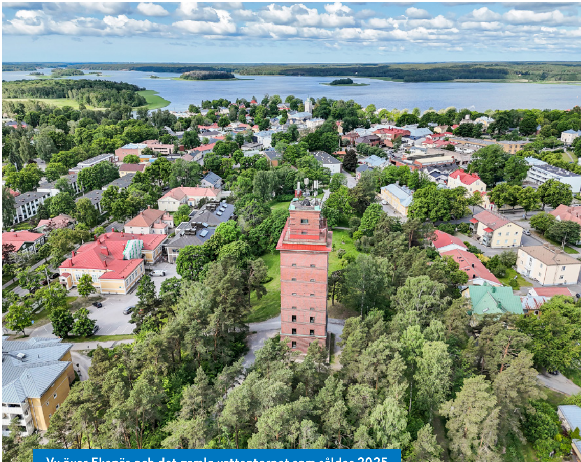
Vy över Ekenäs och det gamla vattentornet som såldes 2025.
