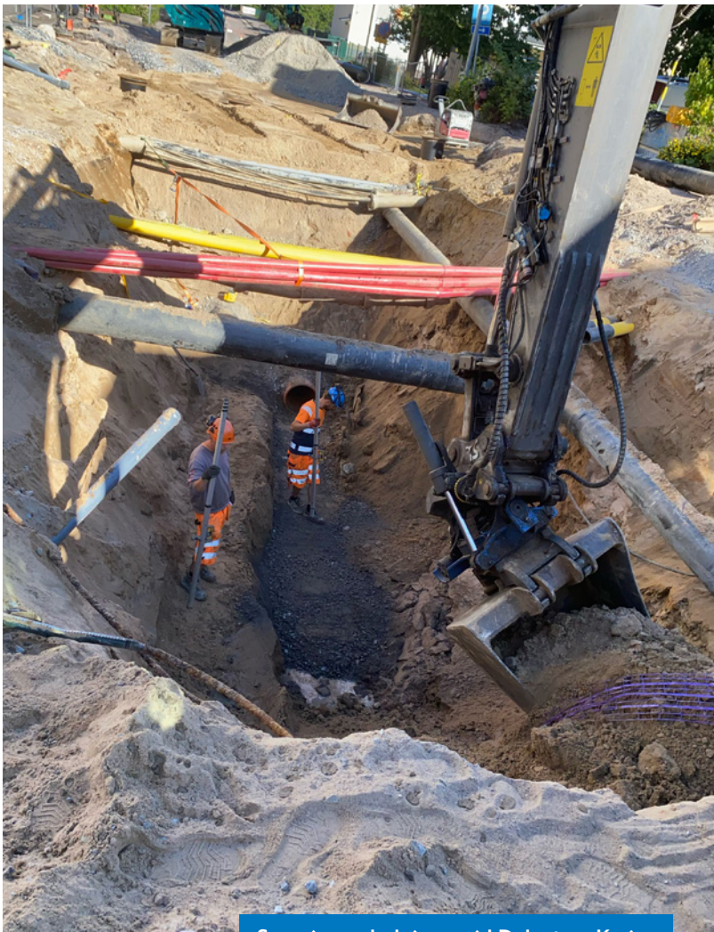
Sanering av ledningar vid Dalgatan, Karis.
