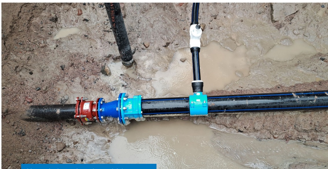
Vattenledningskoppling på Långgatan.
