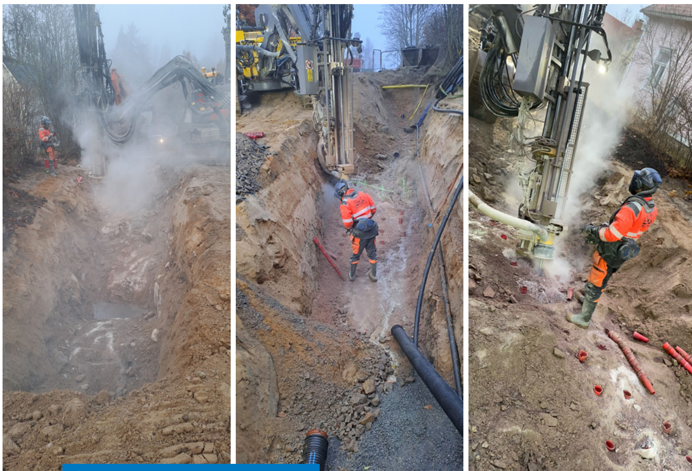
Sanering av ledningar på Berggatan, Karis.
