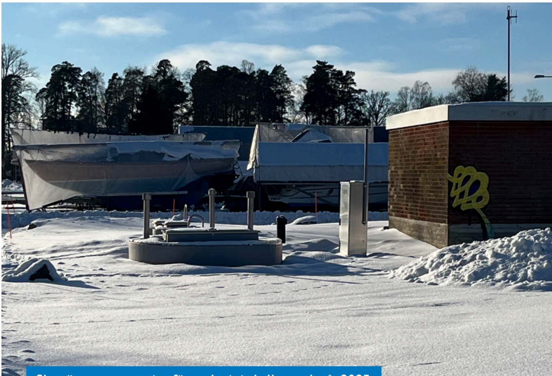
Skutvägens pumpstation förnyades i sin helhet under år 2025.
