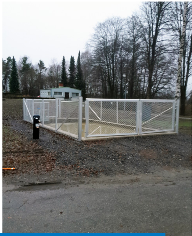
Skeppsholmenin jätevedenpuhdistamon uusi hiekanerotusallas rakennusvaiheessa ja valmiina.
