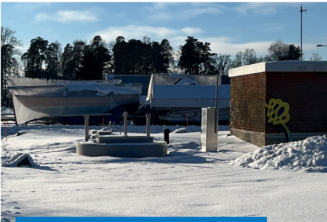
Pursitien pumppuasema uusittiin kokonaisuudessaan vuoden 2025 aikana.
