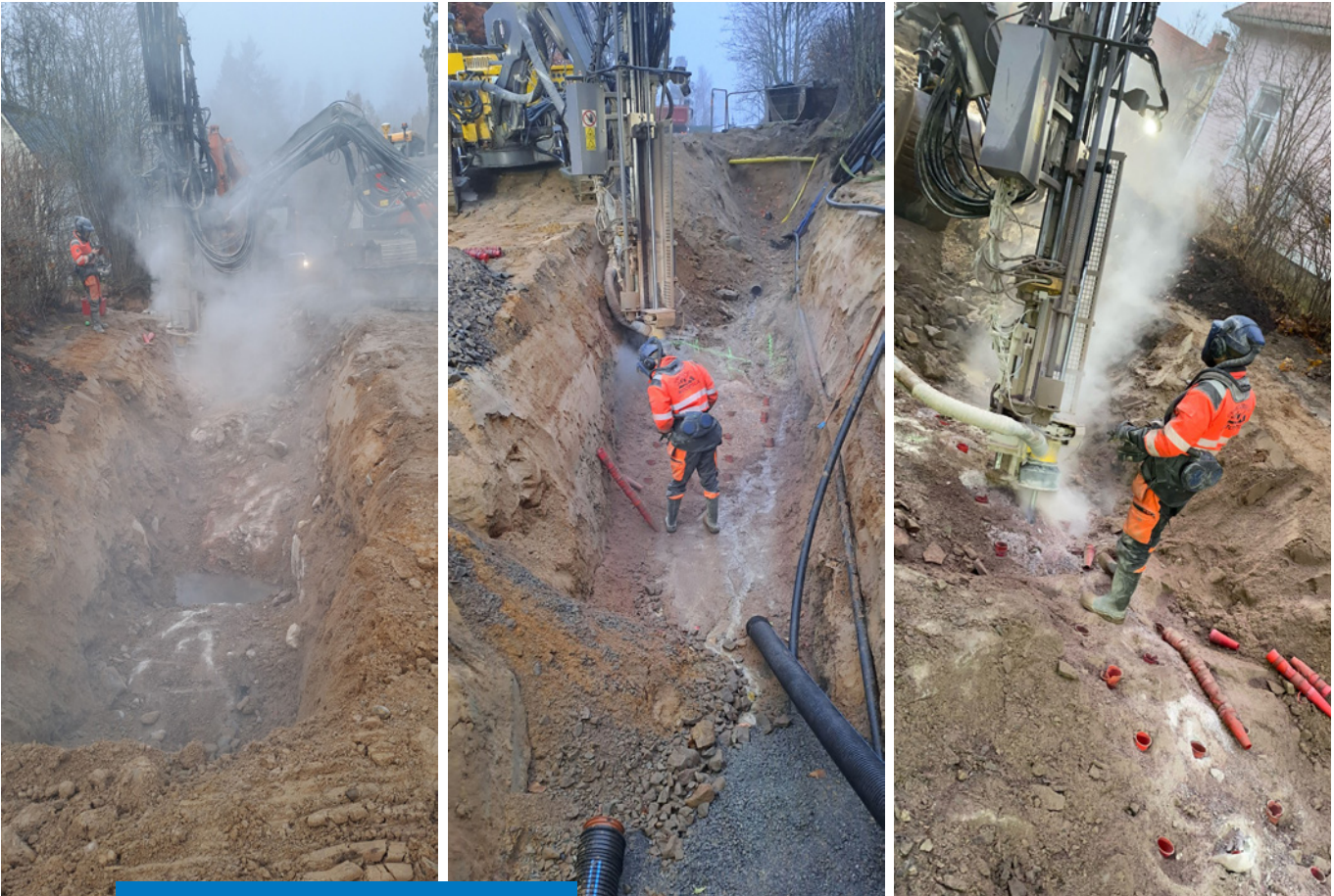
Karjaan Vuorikadun johtojen saneeraus.
