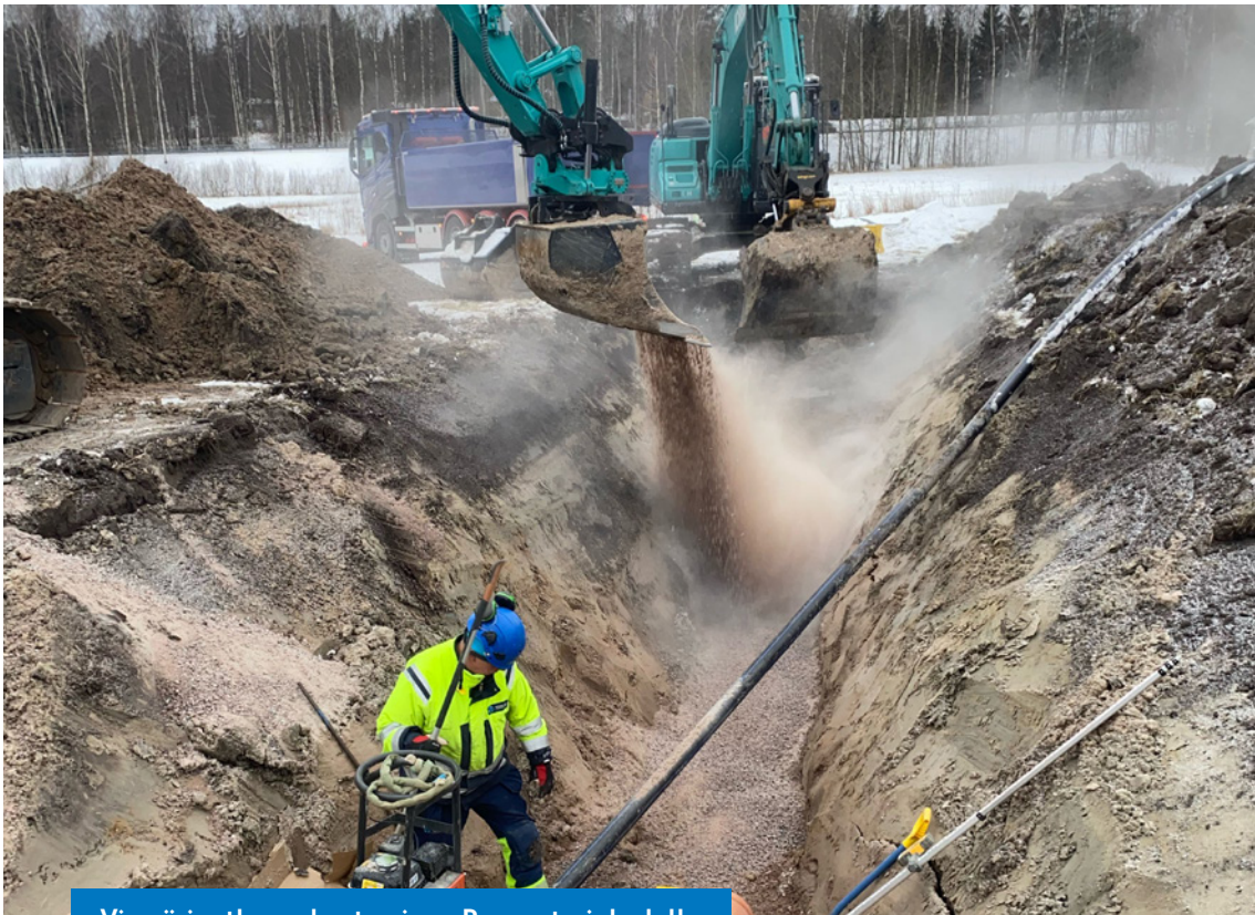
Viemäriputken rakentaminen Pormestarinkadulla.
