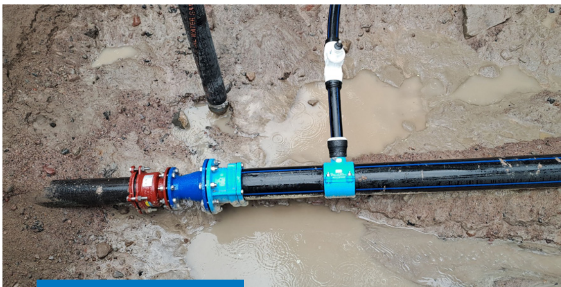
Vesijohdon kytkentä Pitkädulla.
