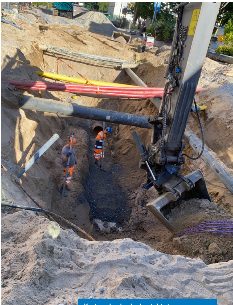
Karjaan Laaksokadun johtojen saneeraus.
