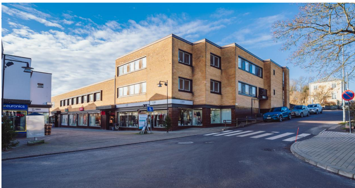
Kuva 2. Näkymä Kuninkaankadun alkukohdasta.
