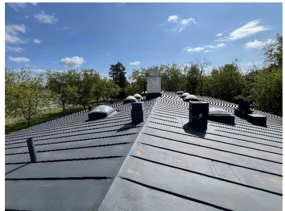
Kuva 54 Matalan osuuden vesikatto.
