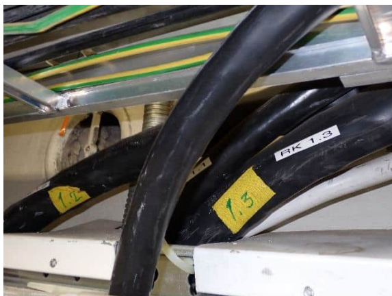
Kuva 79 Liittymiskaapeli
