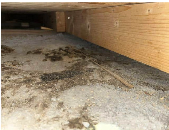
Kuva 8 Rakennearvauksesta RA 16 AP otettu kuva
