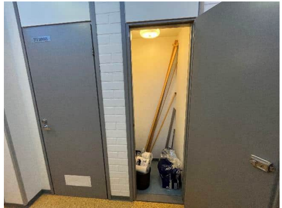
Kuva 52 2. kerroksen komeroiden ovet ovat arviolta muita ovia vanhempia ja myös eri ikäisiä.
