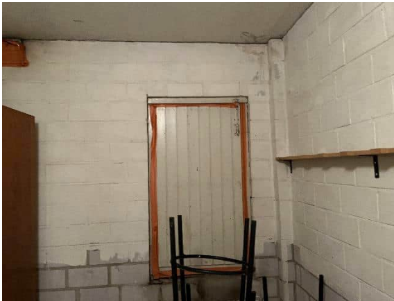
Kuva 31 Suojahuoneen 5 kuorimuurattu maanvastainen seinä. Ovi johtaa maanpinnalle ulottuvaan kuiluun.
