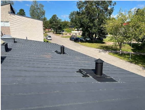
Kuva 55 Matalan osuuden uusittuja hormeja, joiden ympäristöstä vesikate myös uusittu.
