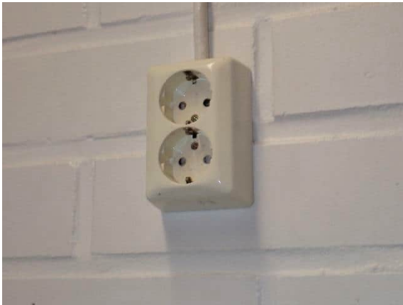
Kuva 92 Pinta-asennettu pistorasia
