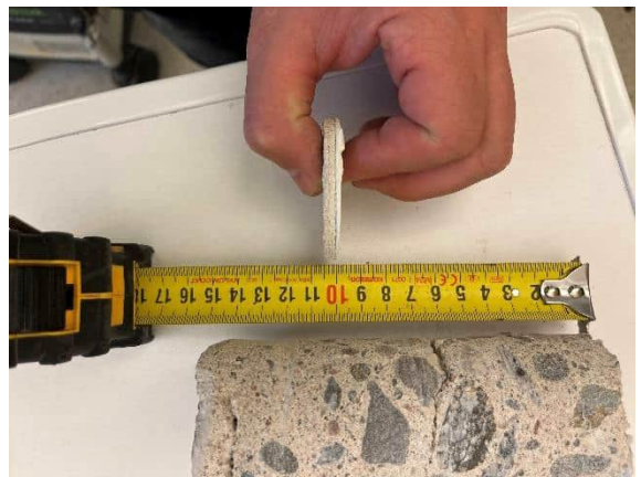
Kuva 3 Rakenneavauksesta RA 06 MVS irrotettu betonilieriö ja pintarakenteet.
