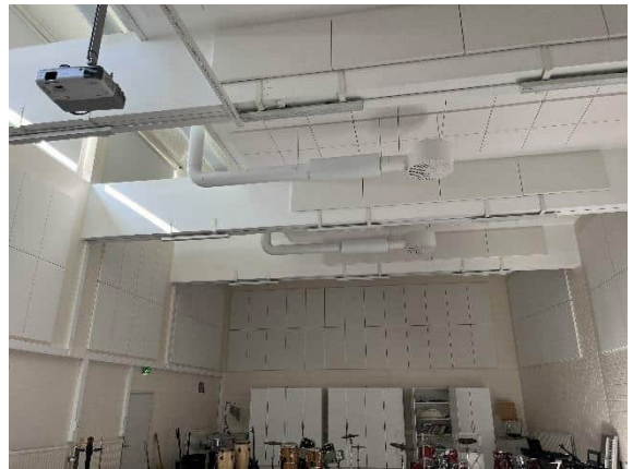
Kuva 18 Auditoriossa kantavina seininä betoni- ja tiiliseinät (vas. ja oik. vastaavasti).
