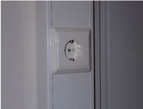
Kuva 77 Johtokanava
