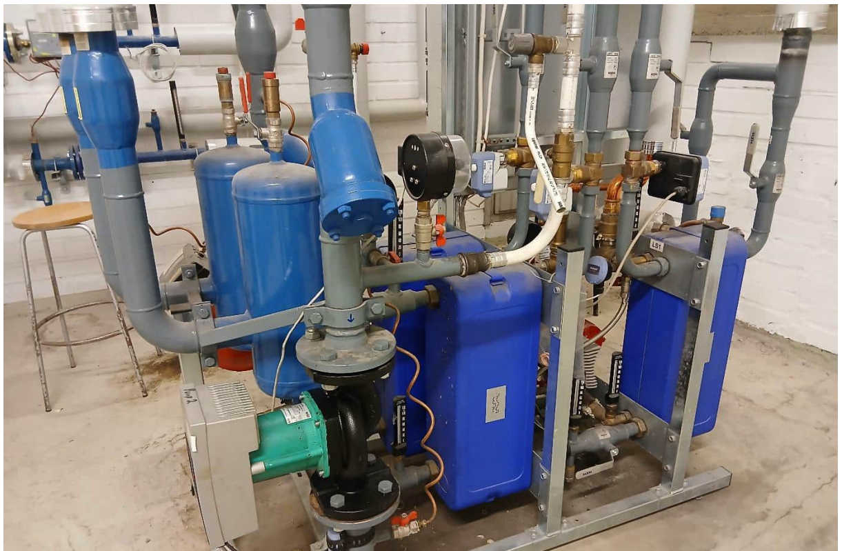
Kuva 59 Yleiskuva kaukolämmönvaihtimesta
