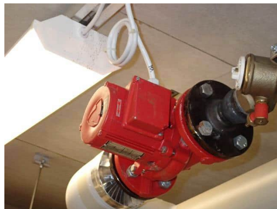
Kuva 91 Kiertovesipumppu
