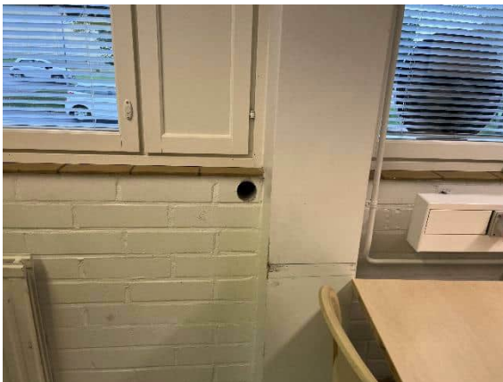
Kuva 19 Ulkoseinän sisäkuori on alimman ikkunanauhan alla tiiltä.
