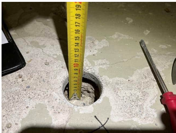
Kuva 2 Rakenneavaus RA 01 AP. Alapohja koostuu eri betonikerroksista.
