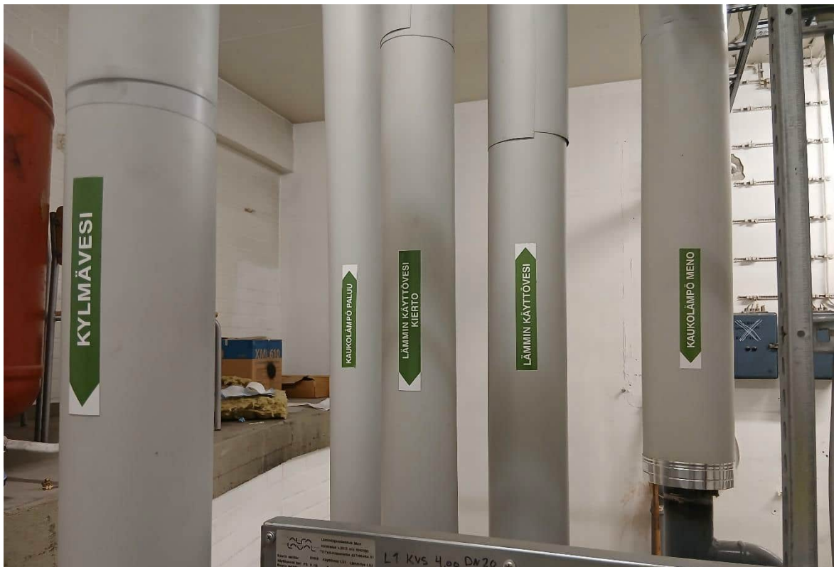
Kuva 65 Käyttövesiputkistoja lämmönjakohuoneessa
