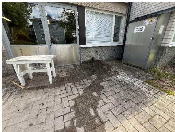
Kuva 12 Puutyötilojen sisäänkäynti lounaisseinustalla. Sisäänkäynnin edessä on hetkeä aikaisemmin pesty mopoja.
