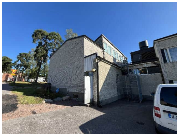
Kuva 13 Auditorio-osuuden kohdalla sisäänkäynnin edustalla on asfalttipäällyste (kuvassa näkyvä hiekka-alue päällystettiin tutkimusten aikana)
