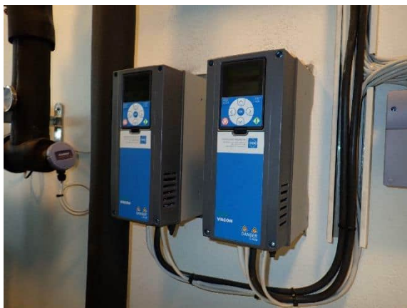
Kuva 90 IV-laitteiden taajuusmuuttajia
