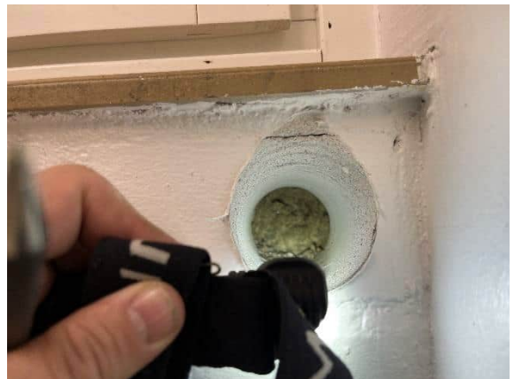
Kuva 20 Ulkoseinien alaosissa lämmöneristeenä on pääosin mineraalivilla.
