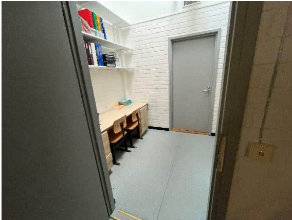
Kuva 49 Luokkatilojen ovat levypintaisia laakaovia
