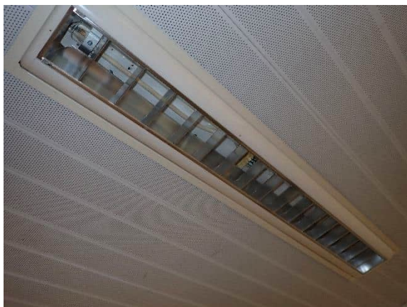
Kuva 94 Viallinen loisteputkivalaisin
