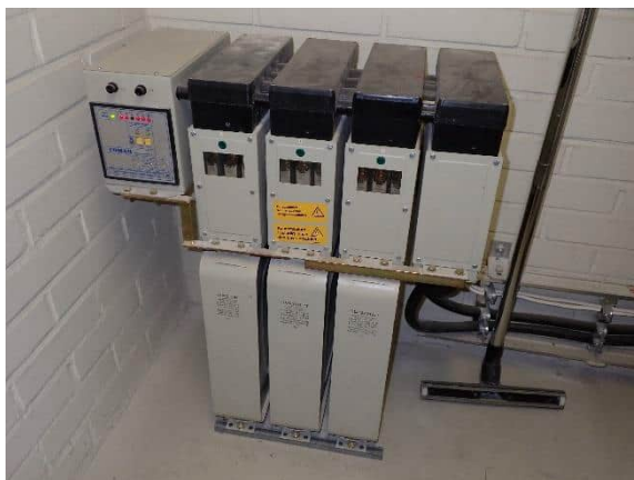
Kuva 88 Loistehon kompensointilaitteisto
