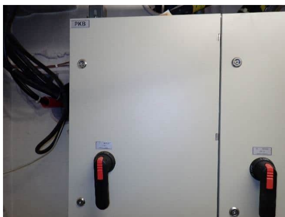
Kuva 80 Sähköpääkeskus
