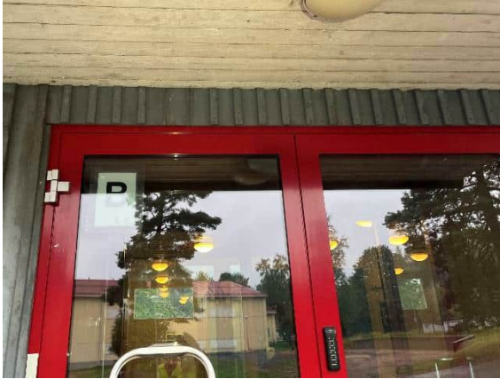
Kuva 45 Auditorio-osuuden sisääntuloaulan uusi ulko-ovi.
