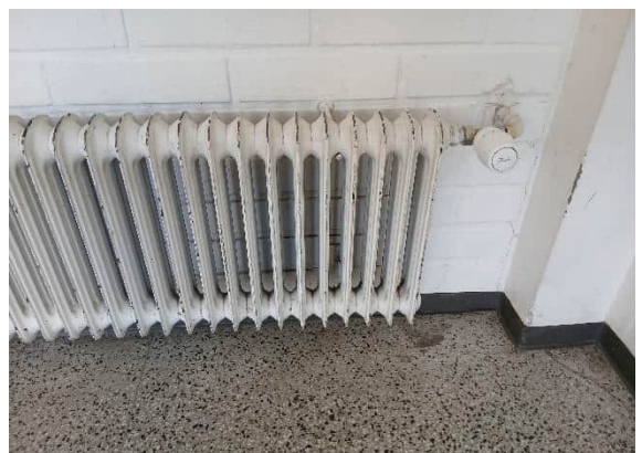
Kuva 63 Putkipatteri
