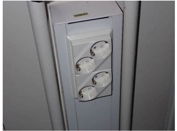
Kuva 78 Johtokanava
