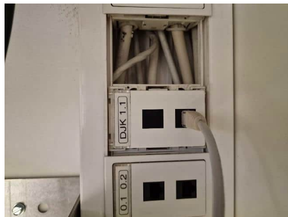
Kuva 101 Yleiskaapelointijärjestelmän RJ45-rasia
