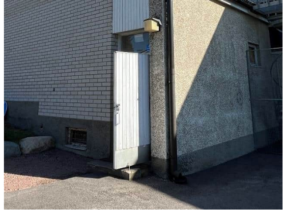
Kuva 46 Ulko-ovi teknisiin tiloihin.
