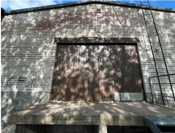
Kuva 47 Konesalin 148 eteläpäädyn vanha ulko-ovi.
