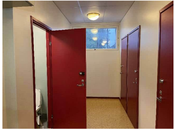
Kuva 50 Aulan 201 WC-tilojen levypintaiset laakaovet
