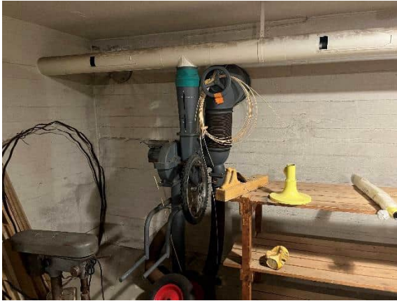
Kuva 29 Entisen VSS:n maanvastaista seinää. Kuvassa näkyy seinän läpivientejä ja VSS-laitteistoa
