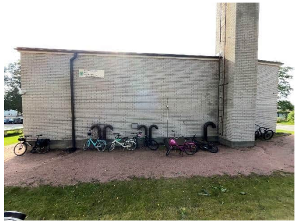
Kuva 58 Auditorio-osuuden vesikatolle ja savupiipun huipulle nousta seinätikkaita.
