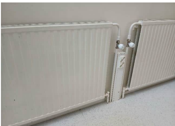
Kuva 62 Yleiskuva teräslevypattereista
