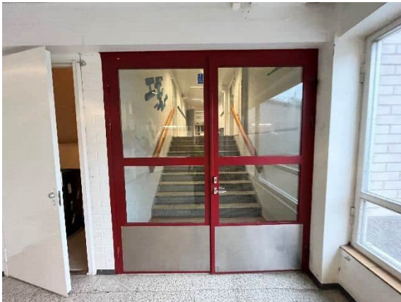
Kuva 51 Käytävän lasiaukollinen palo-ovi oikealla ja metallinen kellarin sisäänkäynnin palo-ovi vasemmalla.
