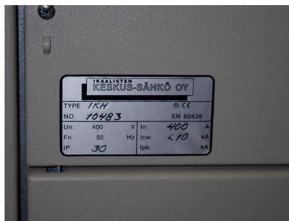
Kuva 81 Sähköpääkeskuksen arvokilpi
