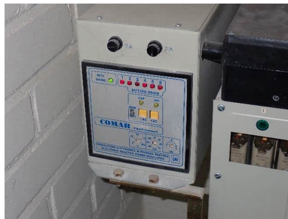
Kuva 89 Loistehon kompensointilaitteisto
