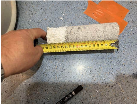
Kuva 4 Rakennearvauksesta RA 11 AP irrotetut rakennekerrokset
