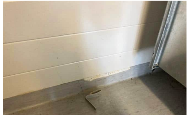
Kuva 3 N02. IV-konehuoneen harmaa muovimatto sisältää DEHP:iä.
