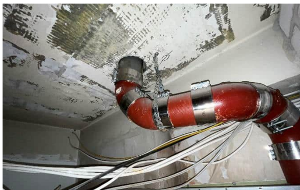
Kuva 26 N26. WC 205. Katon akustovillan liima ei sisällä asbestia.
