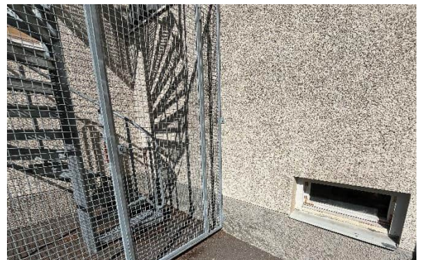
Kuva 5 N04. Julkisivun vaalean harmaa rapaus/betoni ei sisällä asbestia.
