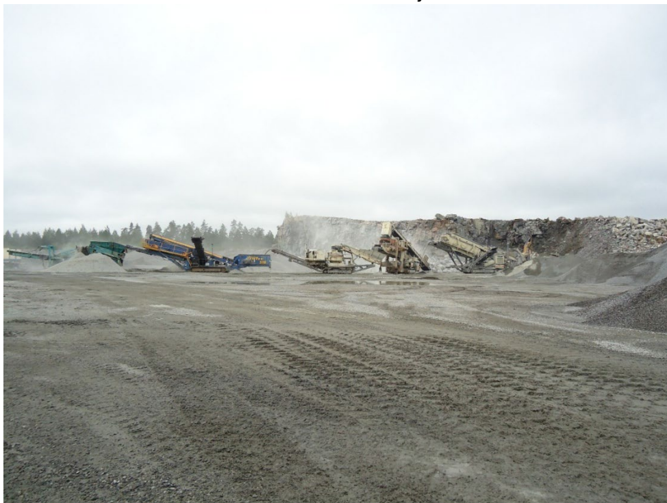
Kivenlouhinta ja murskaus.
