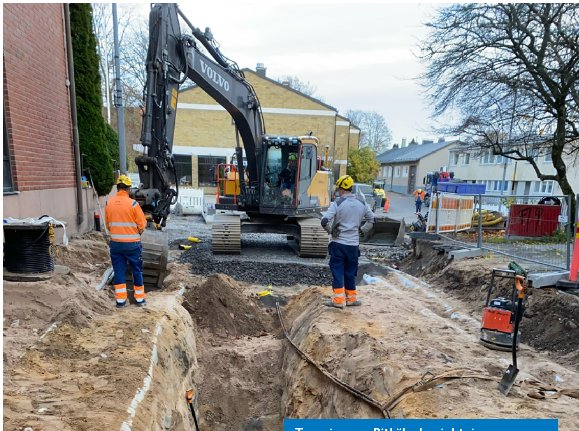
Tammissaaren Pitkädun johtojen saneeraus
