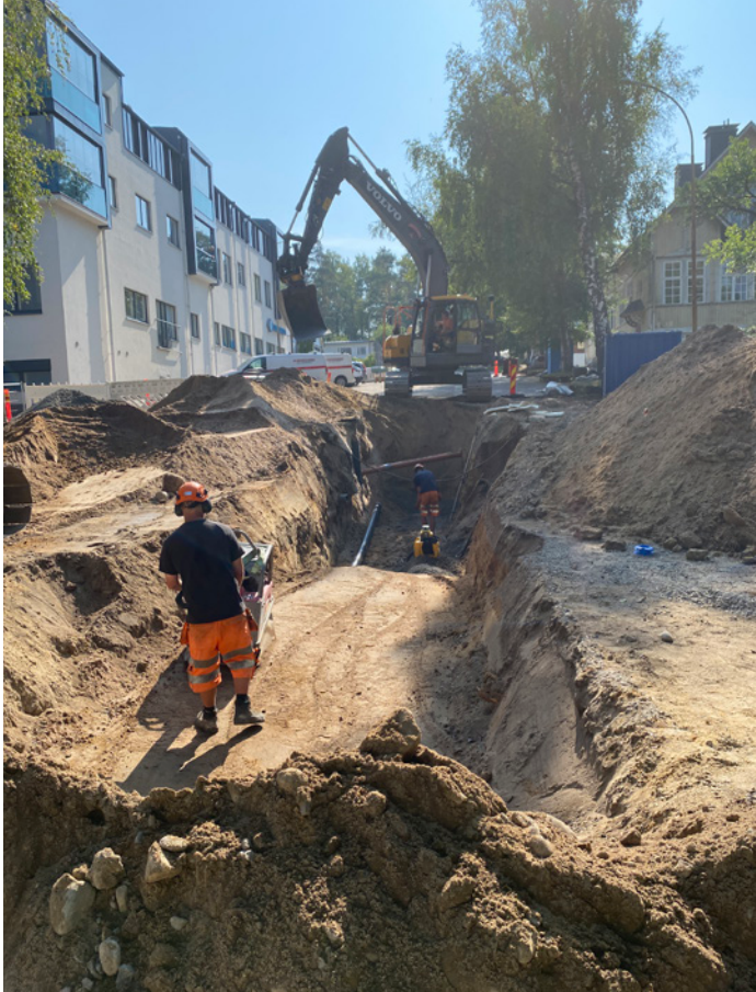
Tammisaaren Koivuniemenkadun ja Tornikadun johtojen saneeraus
