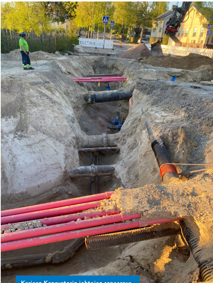
Karjaan Kanavatorin johtojen saneeraus
