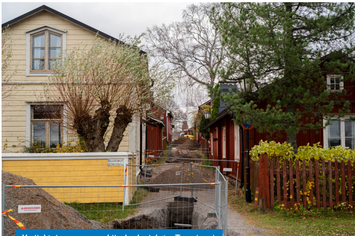
Vesijohtojen saneeraus, Liinakankurinkatu, Tammissaari
