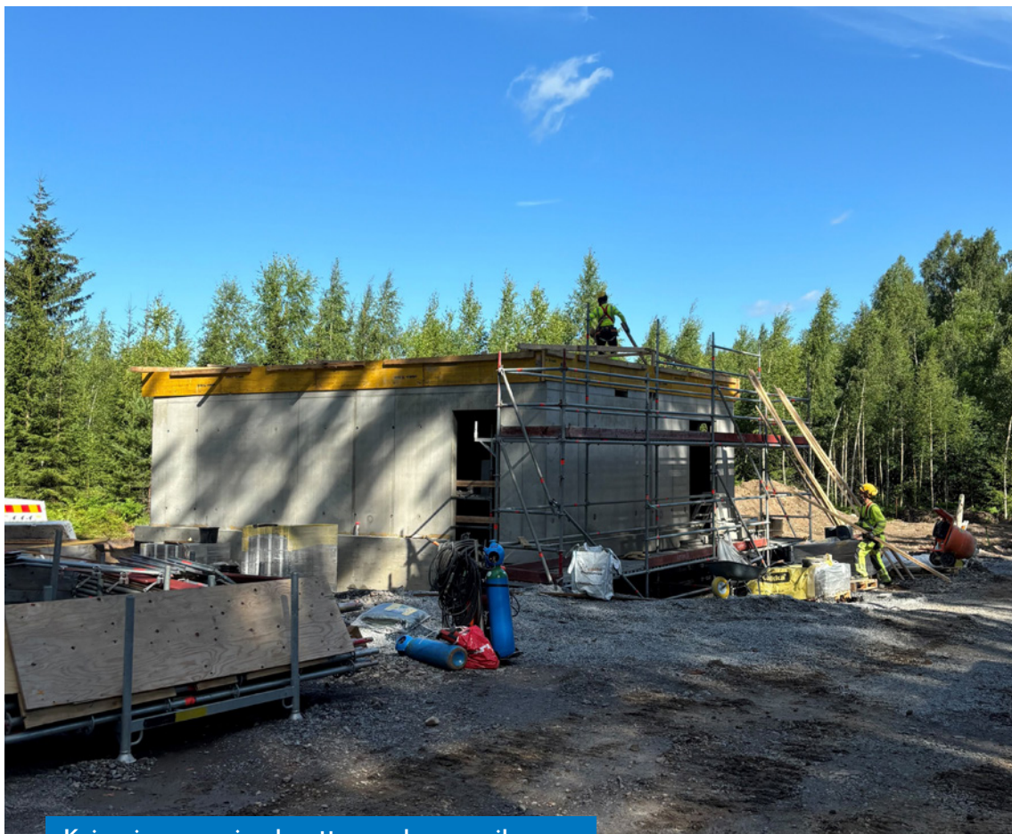
Koivuniemen uusi vedenottamo rakennusvaiheessa
