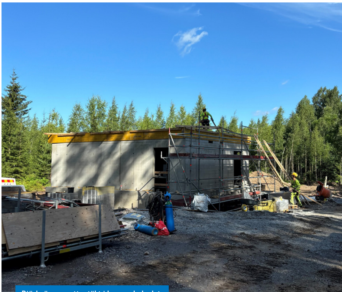
Björknäs nya vattentäkt i byggnadsskedet
