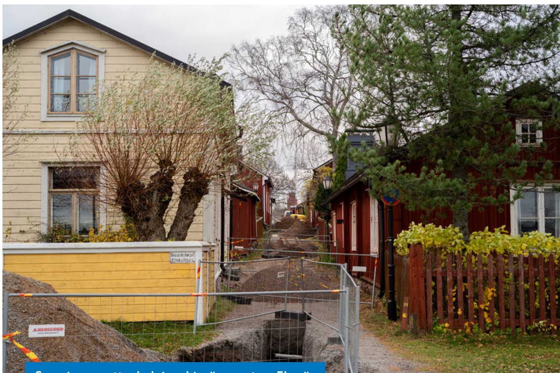
Sanering av vattenledning, Linväwaregatan, Ekenäs
