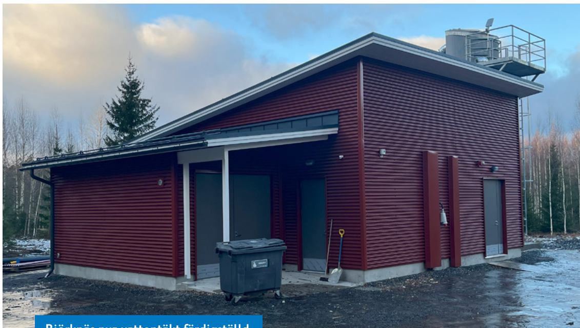
Björknäs nya vattentäkt färdigställd
