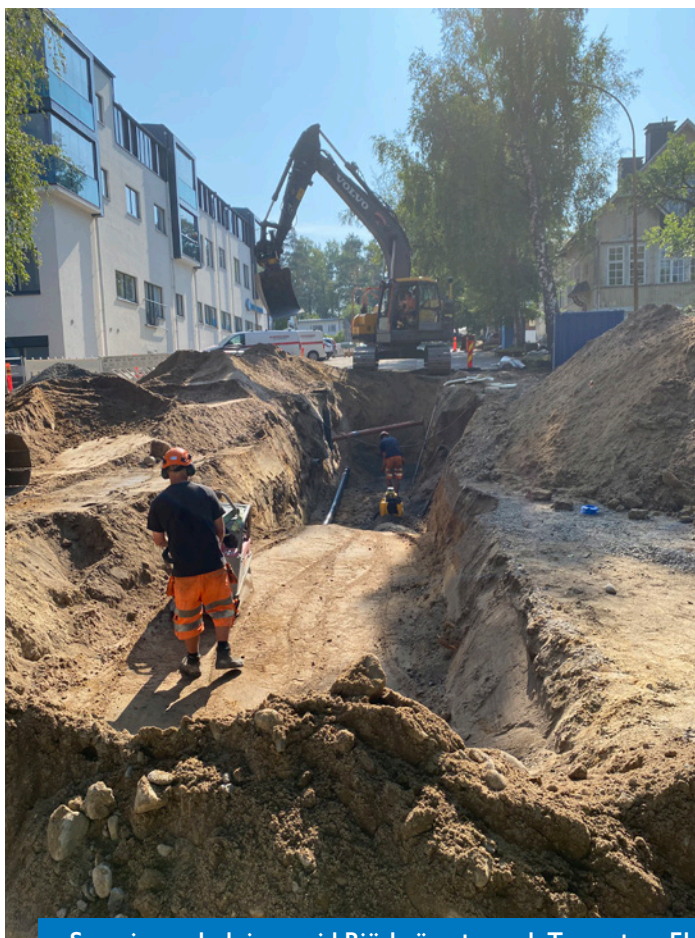
Sanering av ledningar vid Björknäsgatan och Torngatan, Ekenäs
