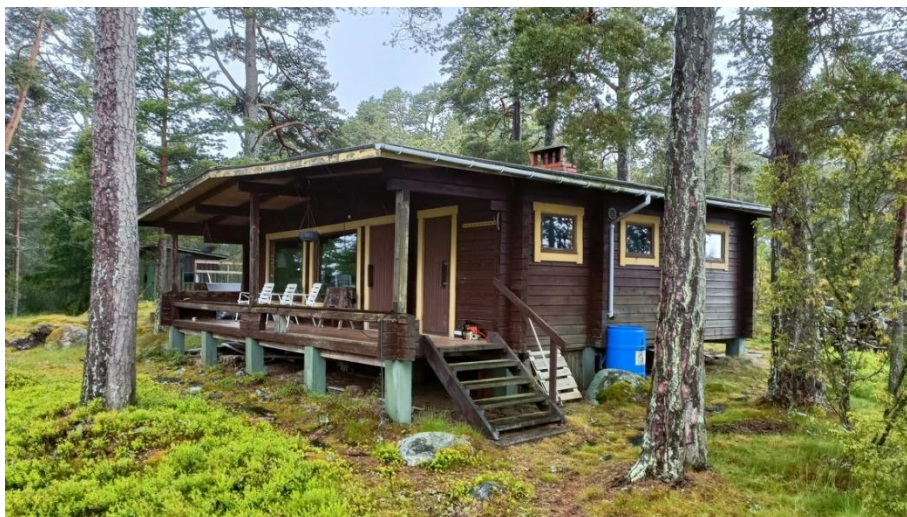
Bild 23. Fritidsbostaden på östra fastigheten.
