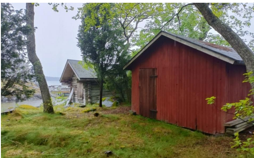
Bild 21. Båthuset och sjöboden på västra fastigheten
