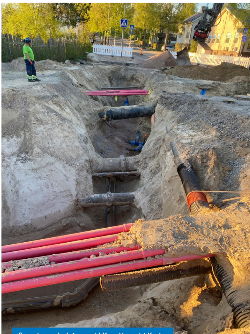
Sanering av ledningar vid Kanaltorget i Karis
