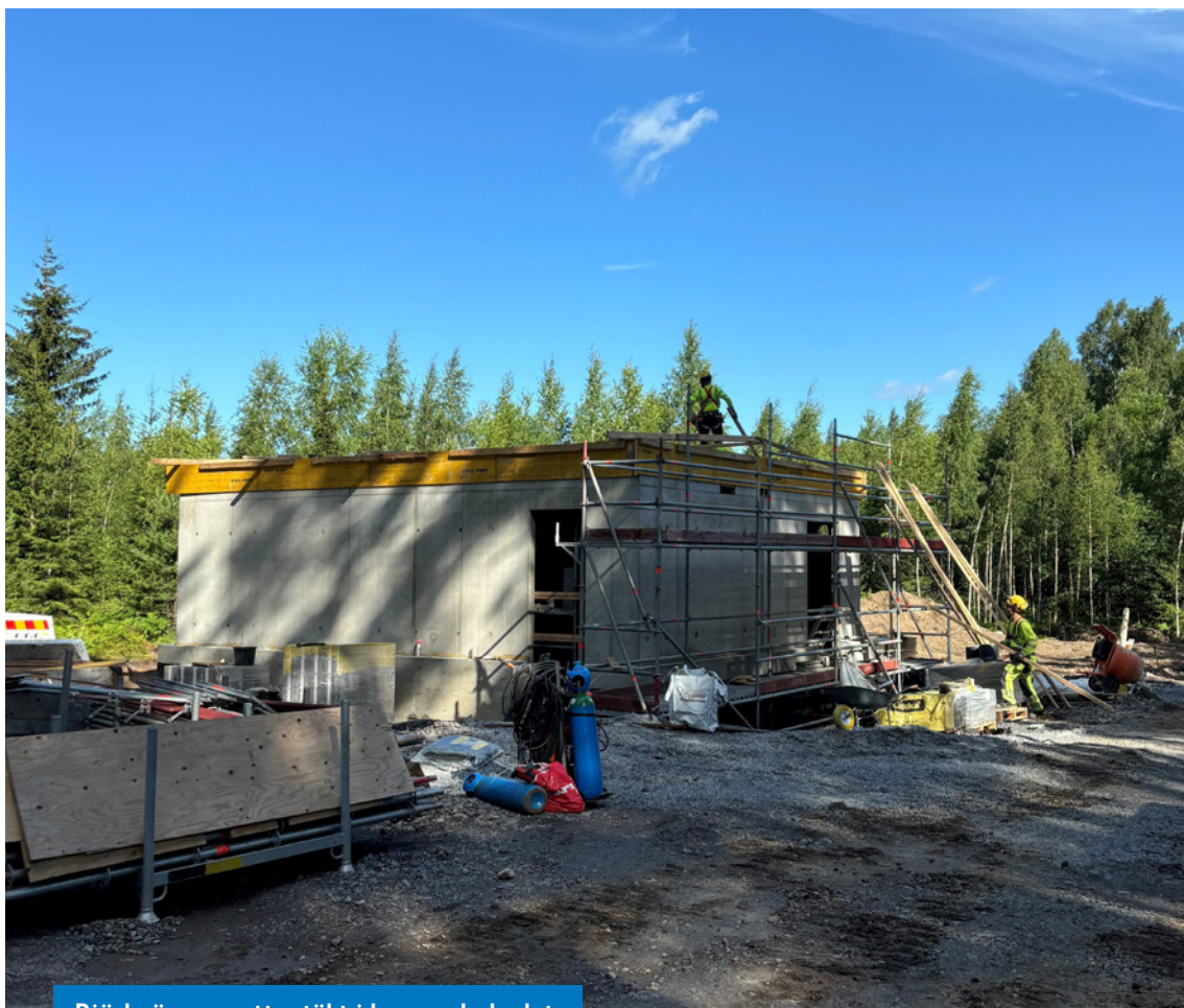
Björknäs nya vattentäkt i byggnadsskedet
