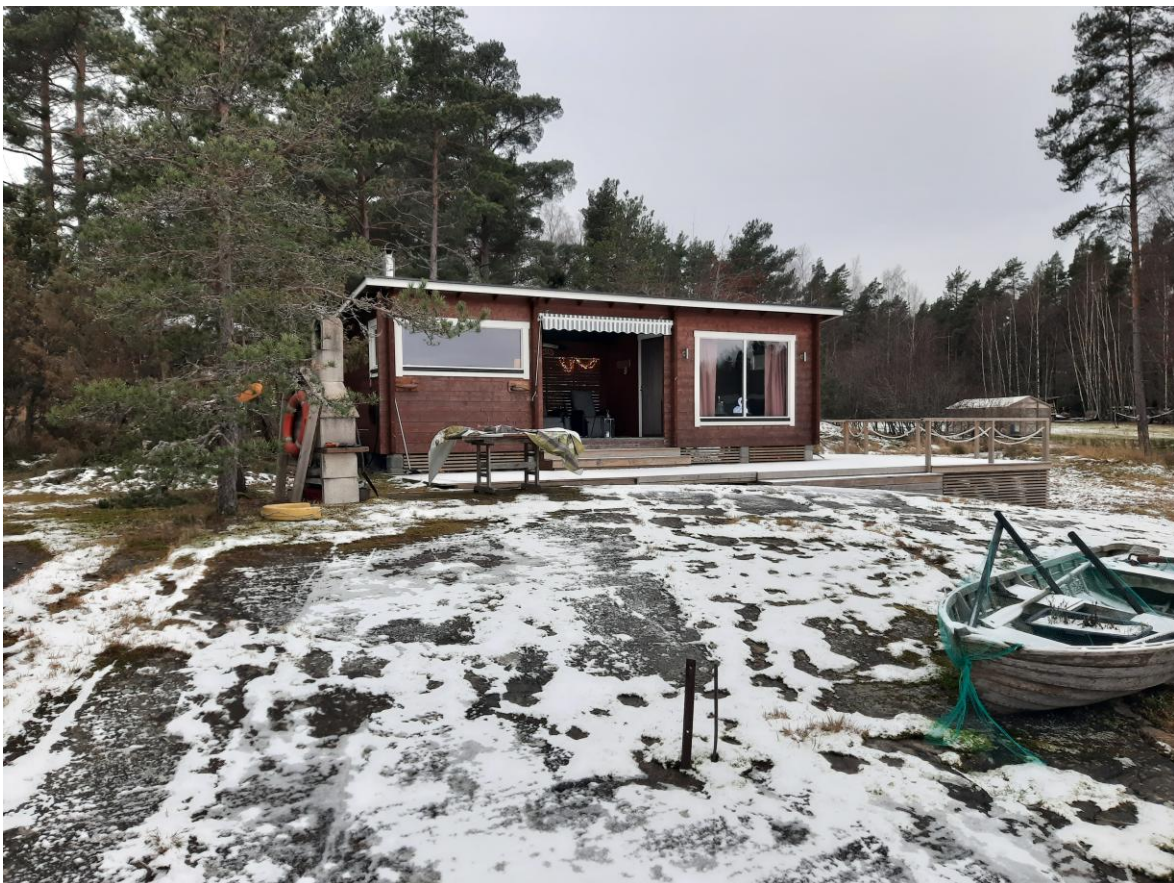
Kuva 10. Kiinteistön Riberget sauna.
