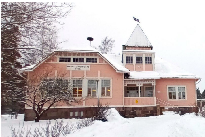
Bild 13. Den gamla skolbyggnaden från 1904 grundrenoverades år 1990.
