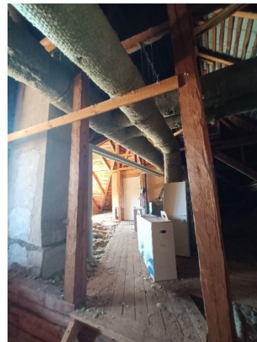
Bild 15,16 och 17. Klassrummen har moderna ytor, nya fönster och modern teknik. Köket är inte på sin ursprungliga plats och har nya ytor och ny utrustning. På vinden har man dragit ventilationsrör och byggt ett maskinrum för ventilationen.
