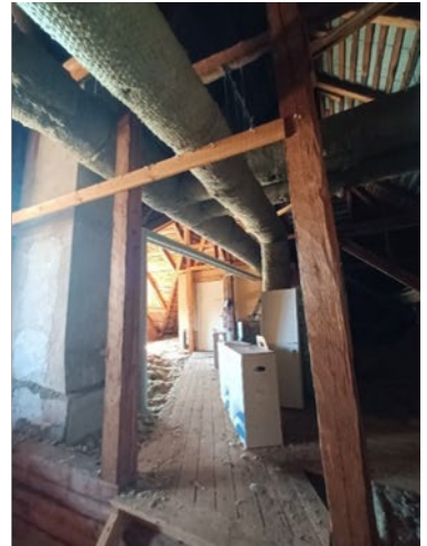
Kuva 15, 16 ja 17: Luokkahuoneissa on modernit pinnat, uudet ikkunat ja moderni tekniikka. Keittiö ei ole alkuperäisellä paikallaan ja sillä uudet pinnat ja uudet laitteet. Ullakolle on vedetty ilmanvaihtoputket ja rakennettu konehuone ilmanvaihtoa varten.
