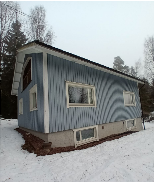
Kuva 13. Vanha Turuntie 109, talo rakennettu 1950–1960-luvulla. Ikkunat uusittu, laudoitus uusittu ja lämmöneristys lisätty. Katto on uusittu.
