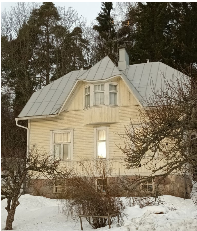
Kuva 7. Vanha Turuntie 97, talo on rakennettu 1910–1920-luvulla. Vanha laudoitus ja vanha palapeltikatto. Ikkunat ovat pääosin vanhoja.
