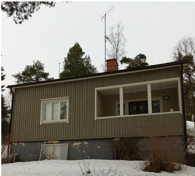
Kuva 9. Vanha Turuntie 101, talo on rakennettu 1930-luvulla. Ikkunat uusittu. Vanha peltikatto.
