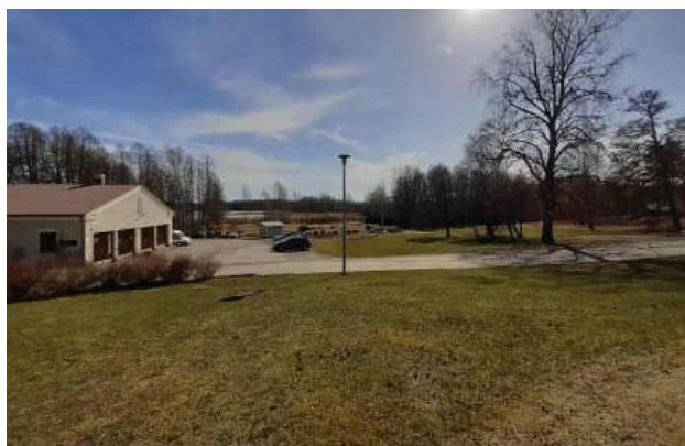
Figur 26. Byggnad sr-1(14) och en ny byggplats.
