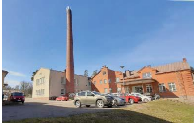
Figur 17. Före detta kosthåll och tvätteri sr-1 (11), innergård.
