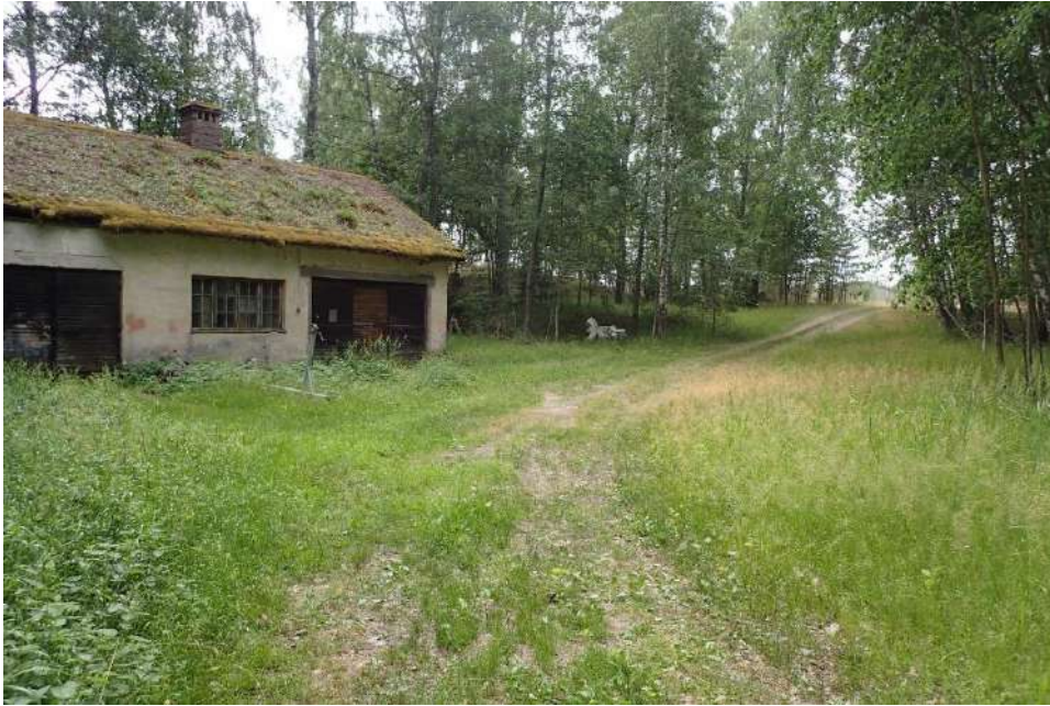
Kuva 26. Vanhan paloaseman lähelle asennettuun laitteeseen 2 tallentui runsaasti lepakkohavaintoja.
