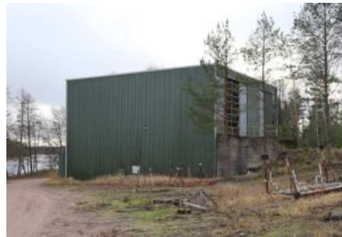
Kuva 23, Lämpökeskus (Stadion ARK)
