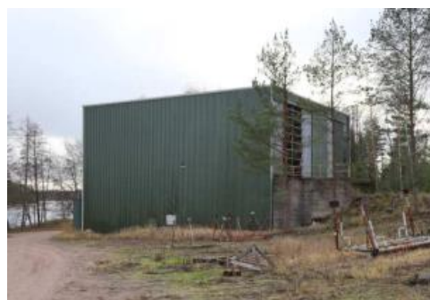
Bild 23, Värmecentralen (Stadion ARK)
