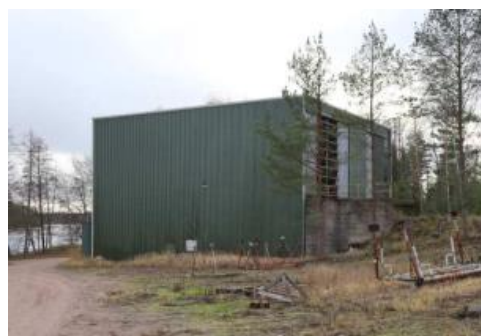
Kuva 23, Lämpökeskus (Stadion ARK)
