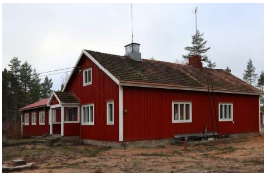
Bild 14, Kontoret (Stadion ARK)
