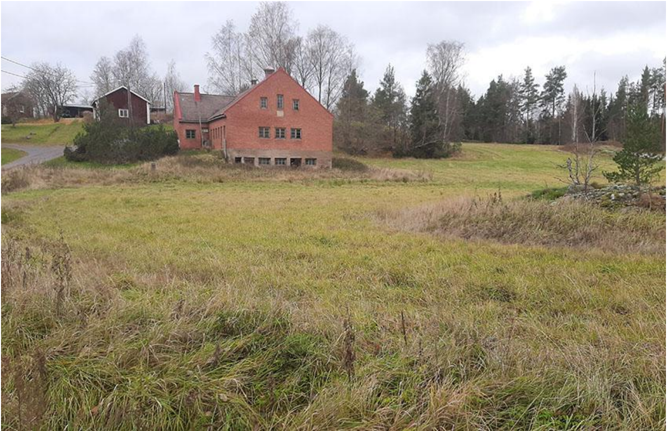
Kuva 2. Navetta on rakennettu poltetuista punatiileistä, katto betonitiilinen.
