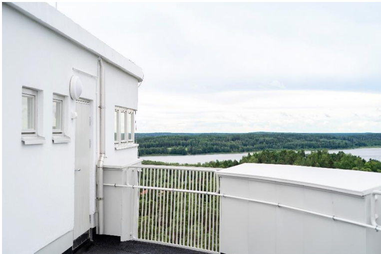
Näkymä Karjaan peruskorjatusta vesitornista
