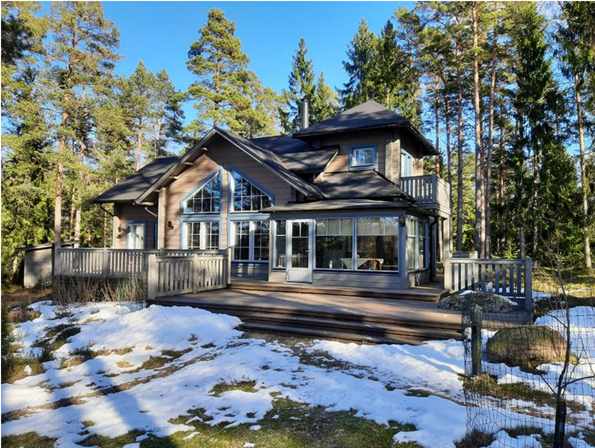
Rakennuspaikalla 1 oleva uudehko päärakennus.
