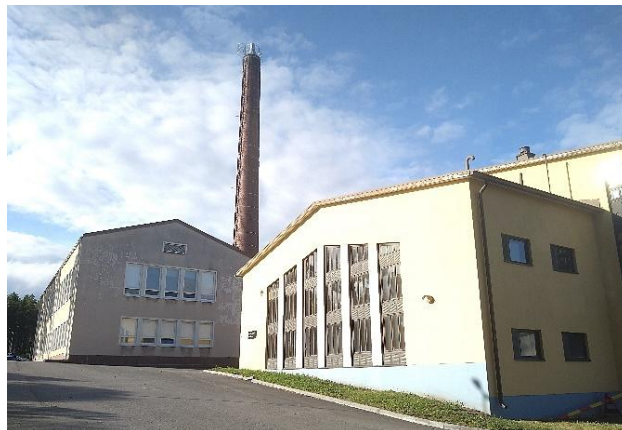
Figur 11. Före detta kosthåll sr-1(3) och värmecentral sr-1(4).
