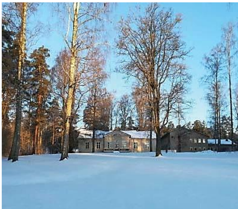
Figur 18. Före detta överläkARBostaden, sr-1(3).
