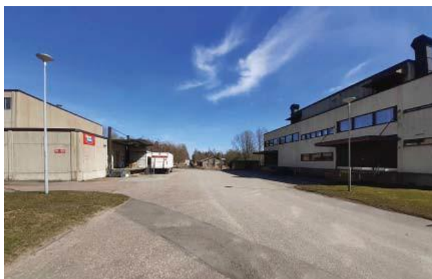
Figur 12. Garnisonsgatan. Tvätteriets lastningsplats till vänster på bilden och kantinbyggnaden till höger.
