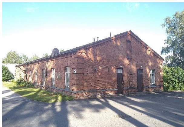
Figur 22. Före detta bageriet sr-1(5).
