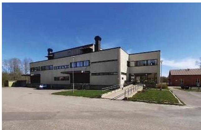
Figur 21. Kantinbyggnaden ('J'-huset), framsidan.
