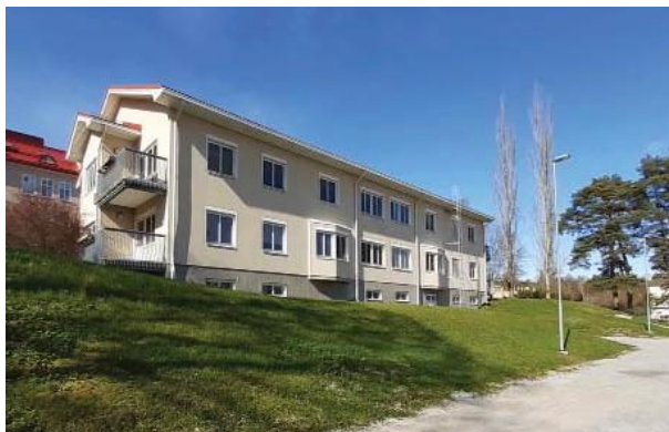
Figur 25. Tilläggsbyggnad söder om huvudbyggnaden.
