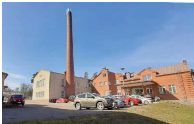
Figur 10. Före detta kosthåll och tvätteri sr-1 (3), innergård.
