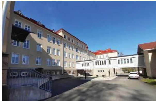
Kuva 26. Päärakennuksen sr-1(1) sisäpiha.
