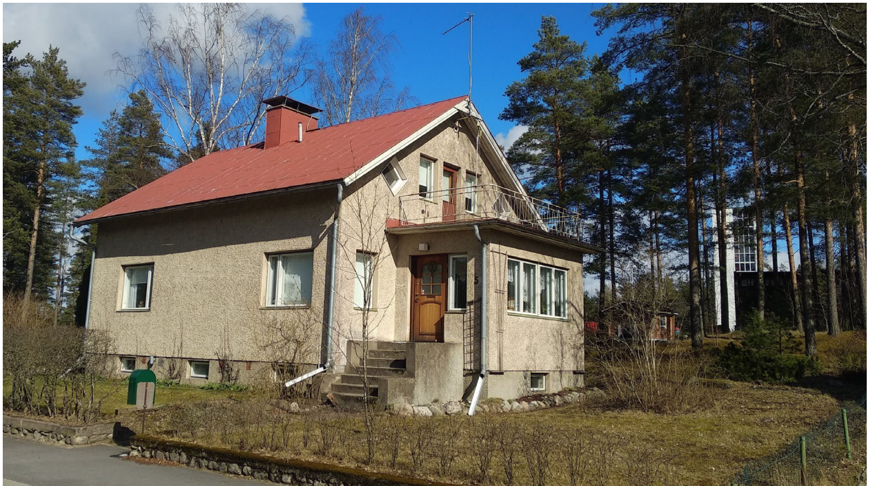
Kuva 5. Trollbergintie 5. Rapattu asuinrakennus, ulkoisesti suhteellisen alkuperäisessä kunnossa.
