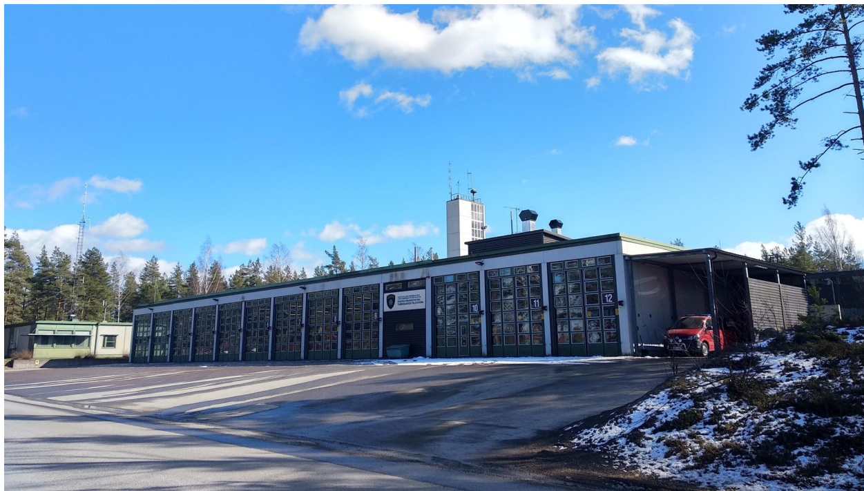
Kuva 2. Tammisaaren paloasema, Oikotieltä katsottuna.
