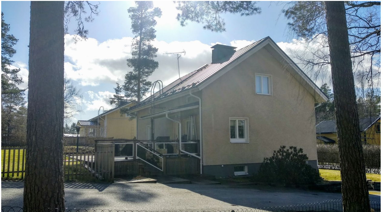
Kuva 4. Trollbergintie 3. Rapattu asuinrakennus, ulkoisesti suhteellisen alkuperäisessä kunnossa.
