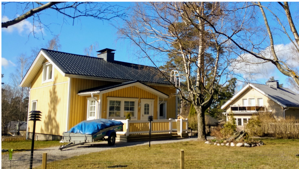
Kuva 3. Trollbergintie 1. Laudoitus, kattomateriaali ja ikkunat on vaihdettu, ja asuntoa on laajennettu vuonna 2002.
