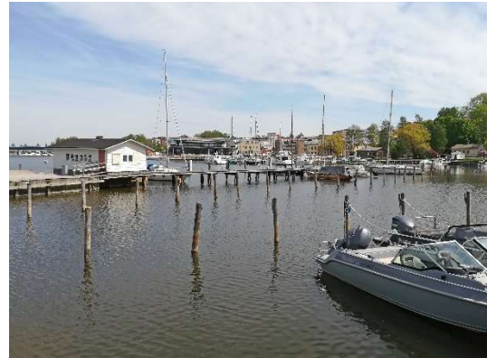
Satama, pyykinhuutelurakennus (sköljhuset)
