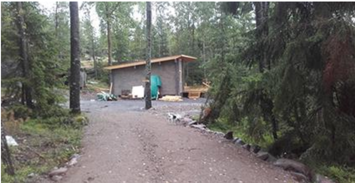
Kuva 12. Korttelin 5 rakennuspaikalla rakenteilla oleva uudisloma-asuntorakennus.
