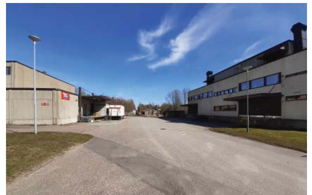
Garnisonsgatan. Tvätteriets lastningsplats till vänster på bilden och kantinebyggnad till höger.
