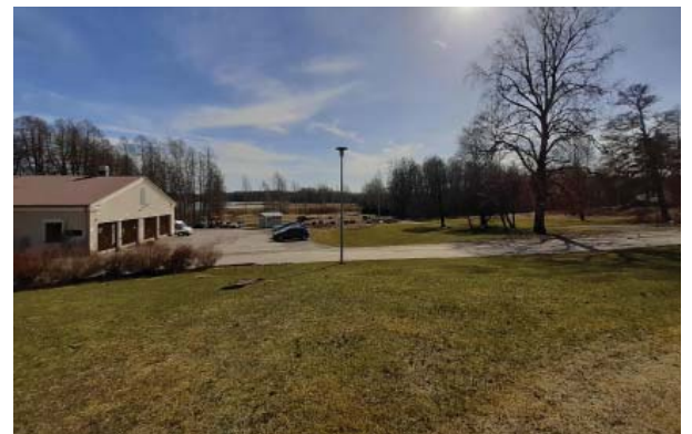
Byggnad sr-1(14) och en ny byggplats.
