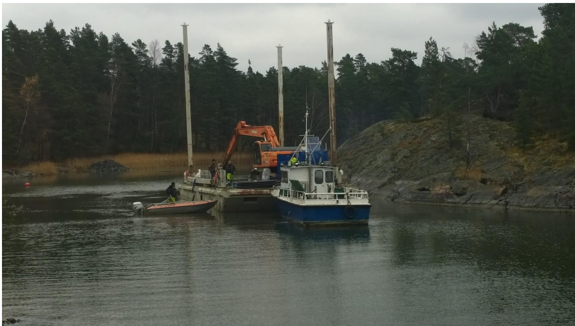
Vesihuoltotekniikan laajennus Skärhallasta Baggön satamaan
