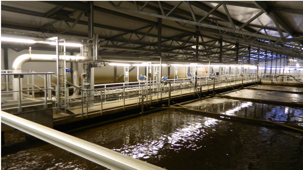
Ilmastointialtaita Karjaan–Pohjan puhdistamolla
