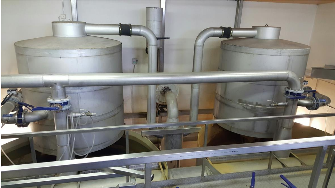
Suodatintekniikkaa Maasillan vedenottamolla
