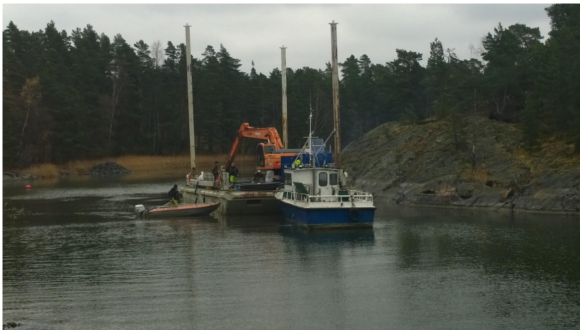
Utbyggnad av vattenförsörjningsteknik från Skärhalla till Baggö hamn foto:Tom Törnroos
